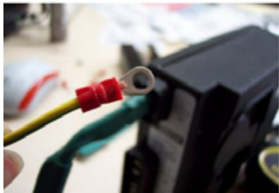
Figure 12 : Connexion particulière câble de terre sur la partie métallique du compresseur
