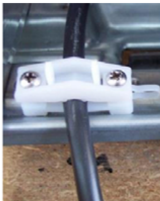
Afbeelding 13: Detail dubbele bevestiging van de kabel
