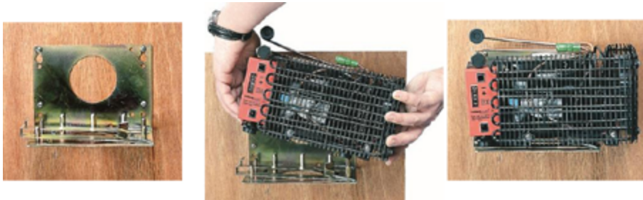
Figure 5 : Détail fixation groupe compresseur - étrier
