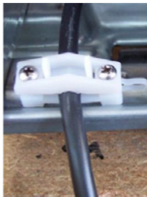
Abbildung 13: Detailansicht doppelte Kabelbefestigung
